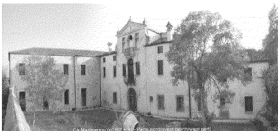
Ca' Martinengo (n° 9/2 + 9) - Parte nord/ovest (north/west part)
